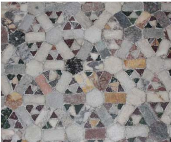
42. Pavimento post desideriano
